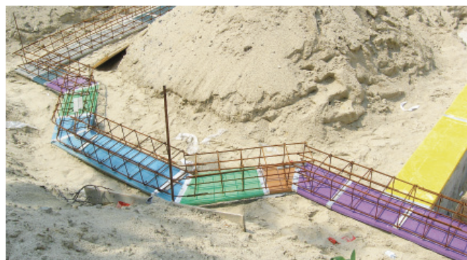
Виброизоляция фундамента здания от вибраций метрополитена
