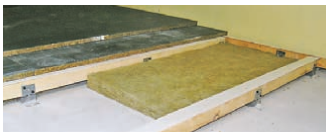
Монтаж «плавающего» пола на лагах
