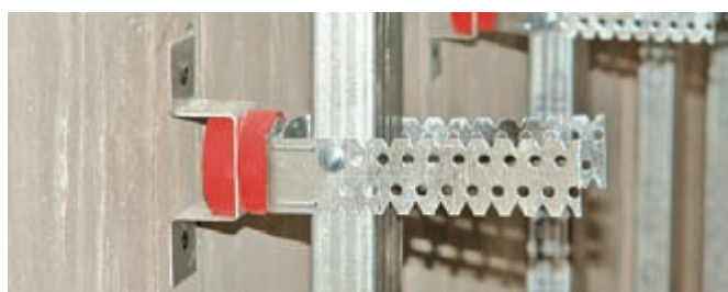
Монтаж звукоизоляционной облицовки
