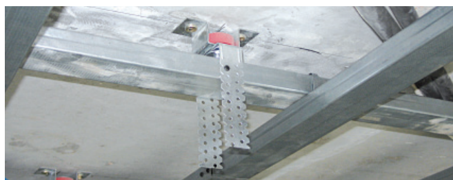
Монтаж звукоизоляционного подвесного потолка
