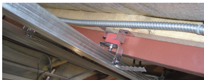
Монтаж звукоизоляционного потолка сложной формы
