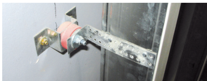
Монтаж звукоизоляционной облицовки большой высоты
